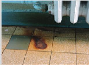
L'apparition d'une coloration rouge indique la dissolution de la rouille par le **dérouillant neutre**
